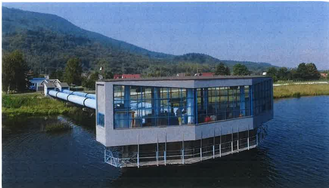
fot.1_Budynek ujęcia wody
