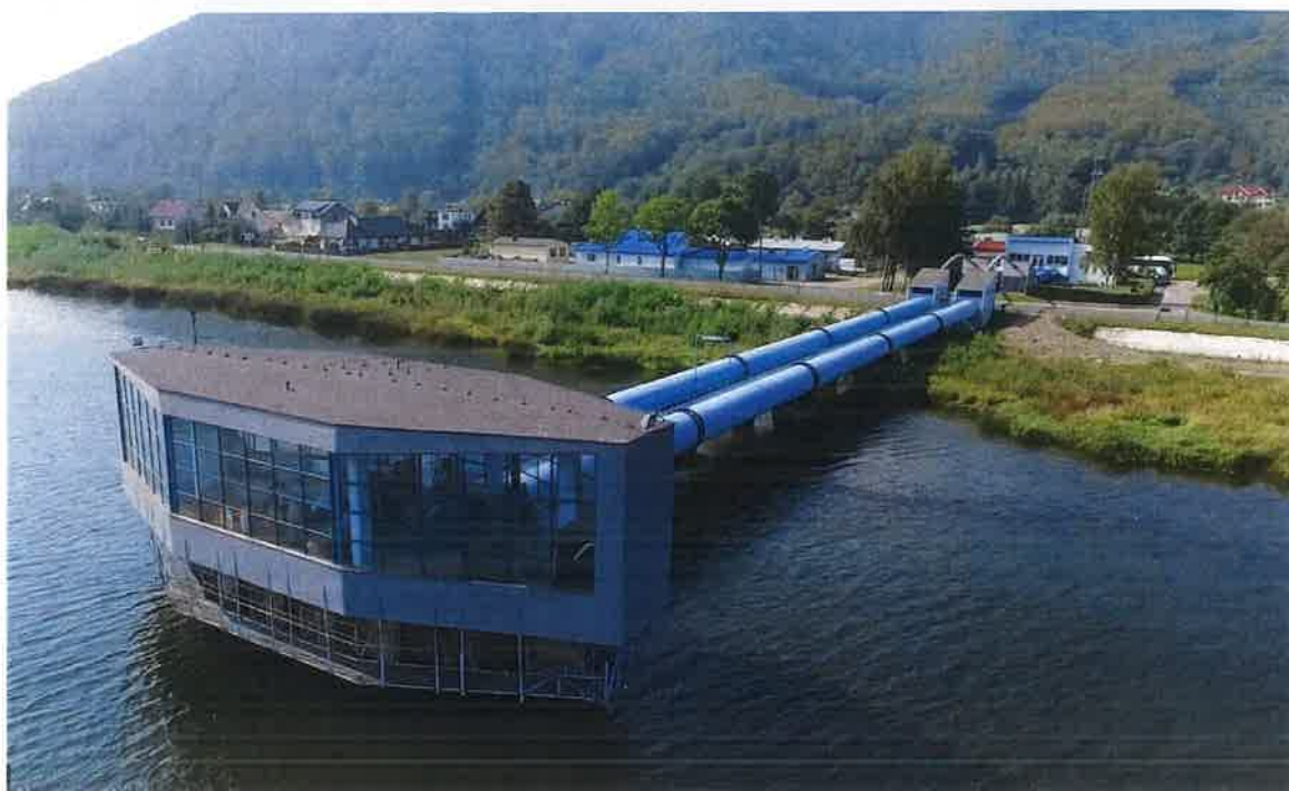
fot.2_Budynek ujęcia wody
