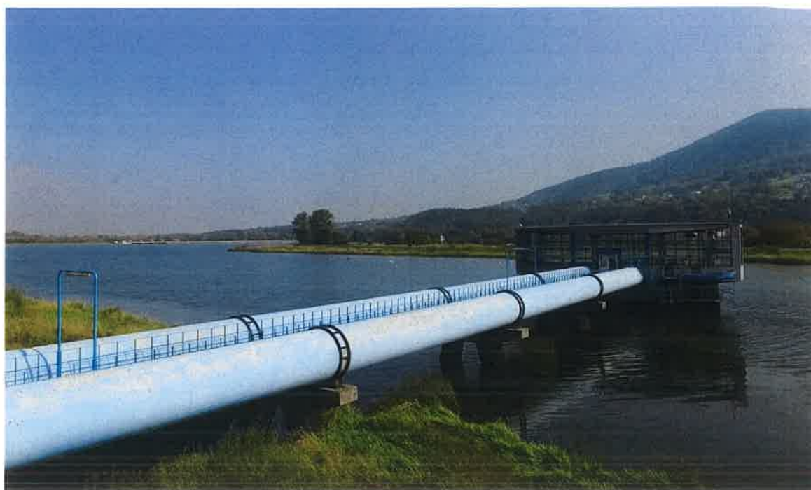
fot.3_Budynek ujęcia wody
